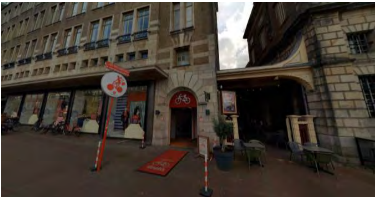
Figuur 8: De Waagstalling, gebouwde fietsenstalling in hartje Leiden
