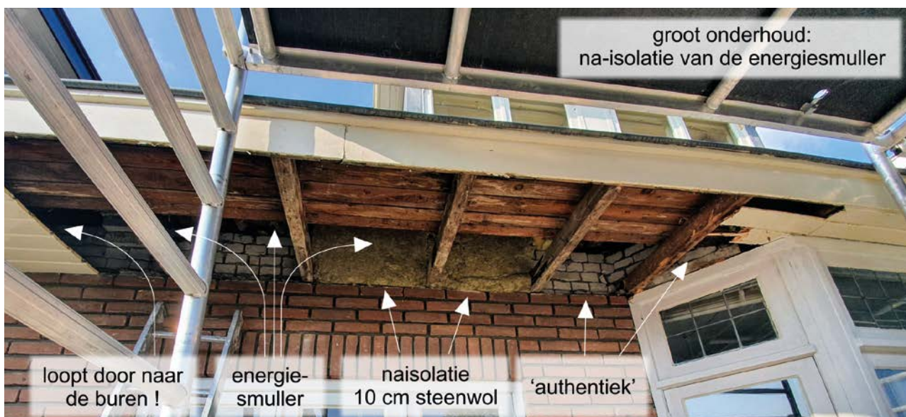
Foto van het overstek genomen tijdens groot onderhoud bij een typische jaren'30 woning in de Profburgwijk. Door verwijdering van de overstekdelen is de energiesmuller goed zichtbaar. Alles staat in open verbinding met elkaar! Een dik pakket steenwol naisolatie deed wonderen aan energiebesparing en comfortverbetering. Foto gemaakt tijdens de naisolatie werkzaamheden.
