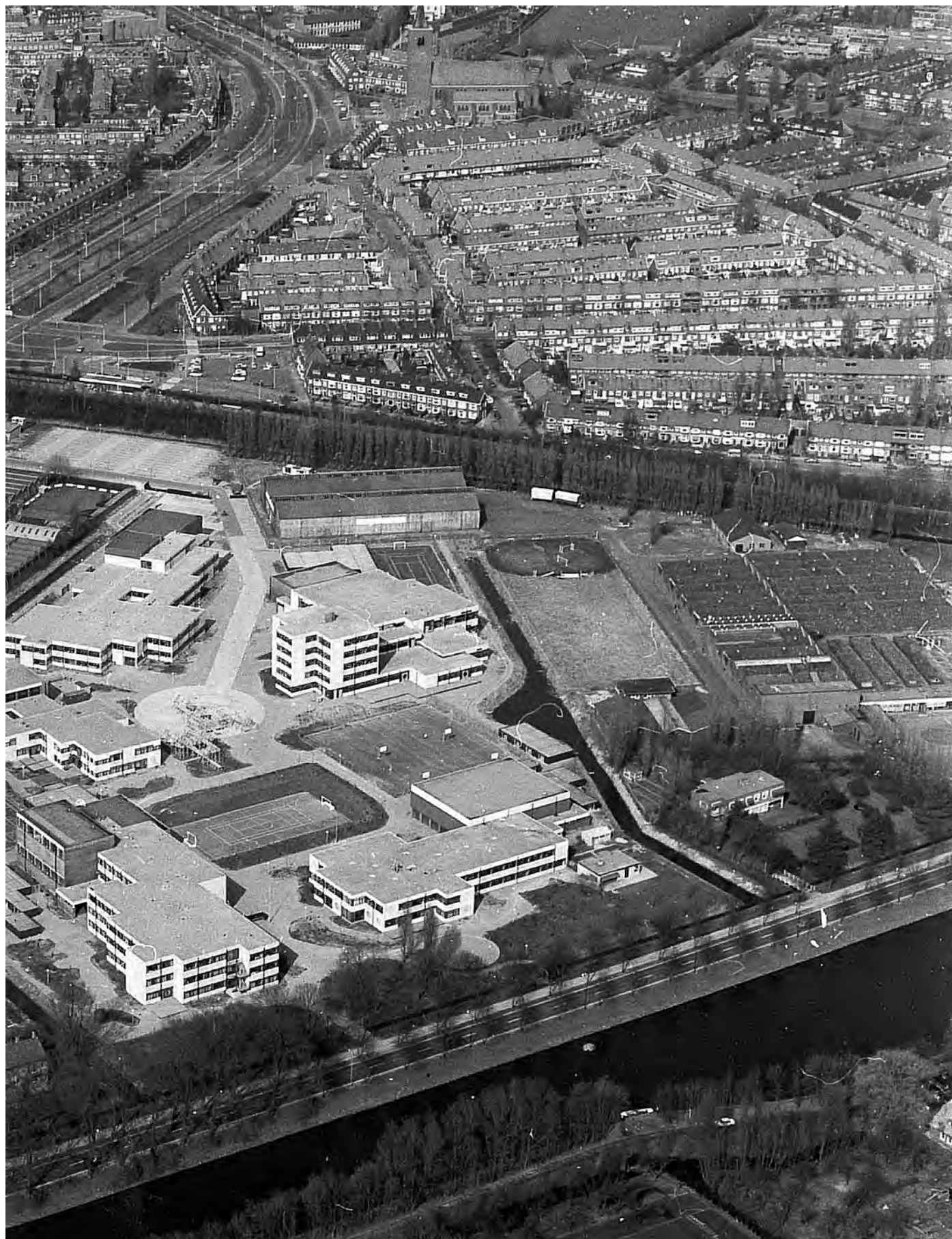
De veroorzaker van het onverwacht asbest is vermoedelijk dekenfabriek Van Wijk die tot eind jaren zeventig een loods had staan op het terrein (midden langs de spoorlijn).
