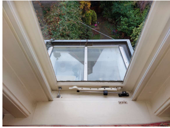
Zicht op dak vanaf binnen
